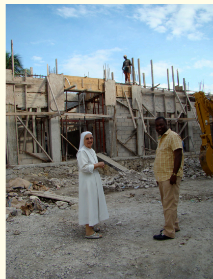
Foto del cantiere inviata da Suor Anna
