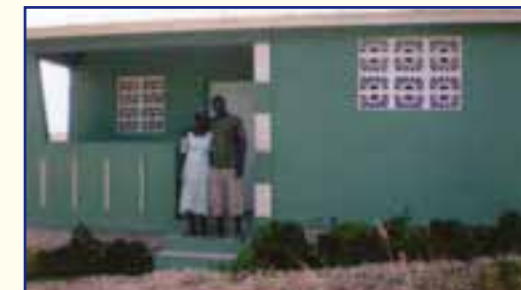
Alcune delle 13 casette realizzate
